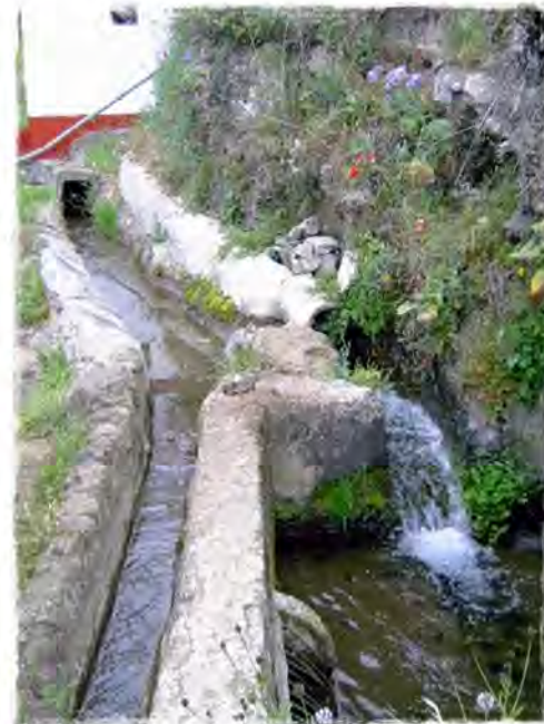
Foto 02 Lavadero de Barranco del Sao, Las Lagunetas. Foto Carmelo Ortega Santana año 2005
